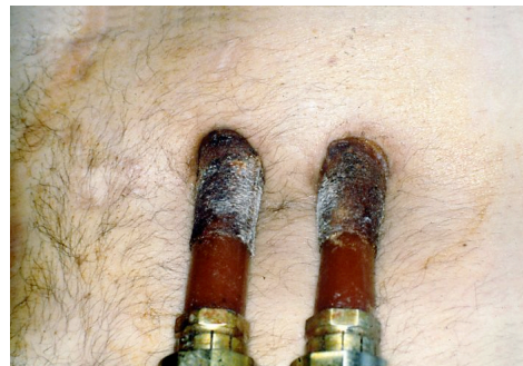
Fig 4 : Câbles de sortie
